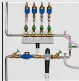
Промывка сантехнического оборудования питьевого водоснабжения (S/SL/SLW)
