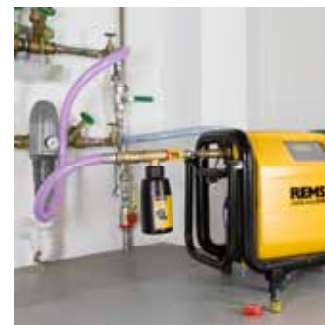
Дезинфекция сантехнического оборудования питьевого водоснабжения
